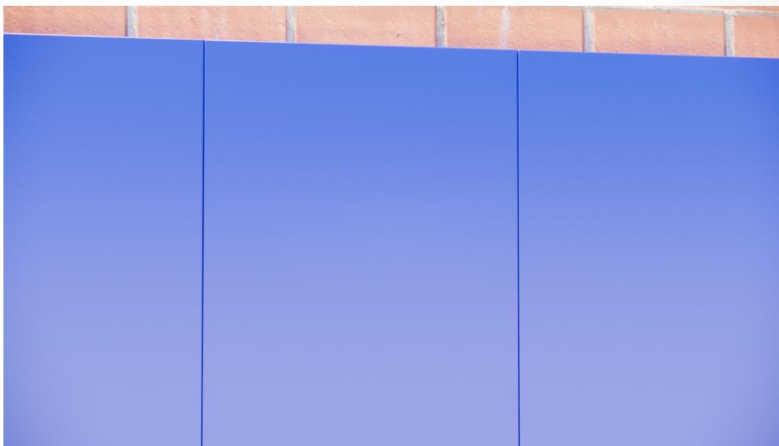
A fixação dos painéis é feita com fita dupla-face (específica para ACM) sobre um perfil tubular de alumínio ou barra chata.
